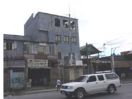
警報サイレン
