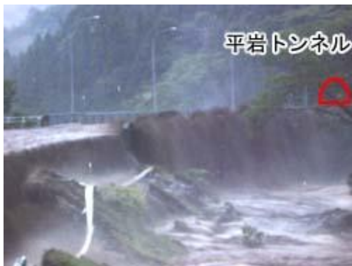
道路の寸断、橋梁の流失
