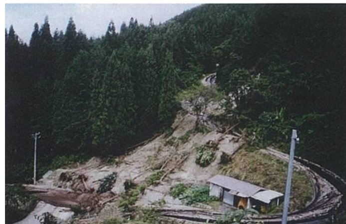
林地崩壊により林道・農地を埋めた土砂／小笹原 木流地内
